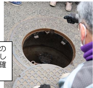
今泉小学校の地下には、災害用飲料水貯水タンクがあります。水道管に接続されているので、常にきれいな水が流れているとか。
